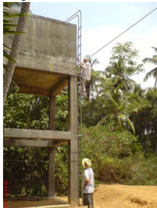
Abb. 19 Wasserturm im ehem. Flüchtlingscamp
