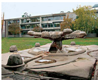
Abb. 1 Arnoldbrunnen vor der Sanierung
